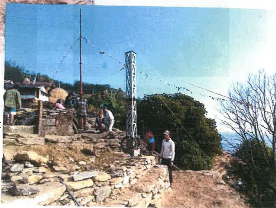
No.2 索道支柱設置工事風景
