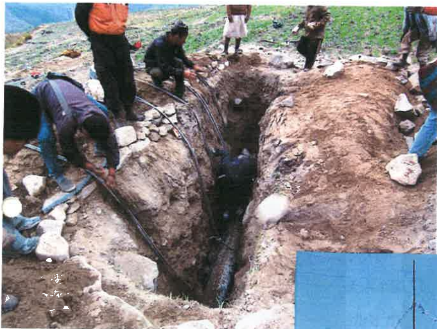
No.3 索道アンカー設置工事
