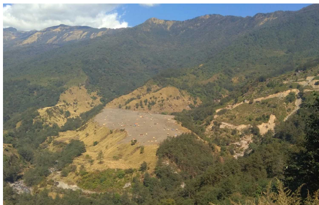
進む道路建設
