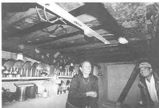
●配線の終了した家屋内部、蛍光灯がつくようになっている ＝1999年3月5日
