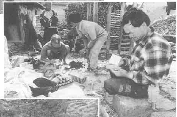
● 急ピッチで進む村内配線工事、作業員はすべて電気工事の研修を受けた村の人達である＝1999年3月5日
