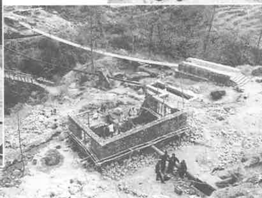
● 発電プラント工事、建物がほぼ姿を現わした＝1999年3月5日
